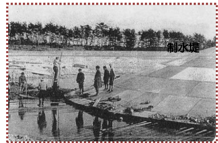
写真-2 第 10 号制水横堤の頭部（工事中）
