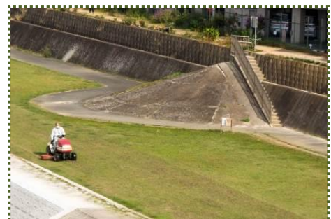
写真-5 左岸の制水堤頭部
