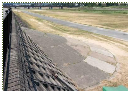
写真-4 右岸の制水堤頭部
