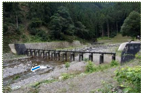
写真-16 鋼製透過型砂防堰堤
