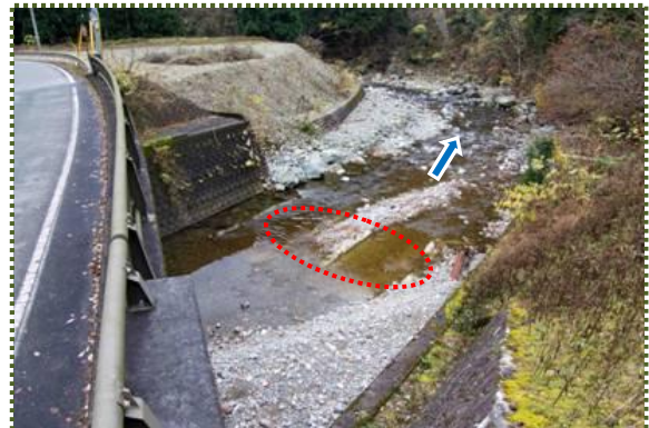
写真-14 平野橋から木橋跡を撮影
