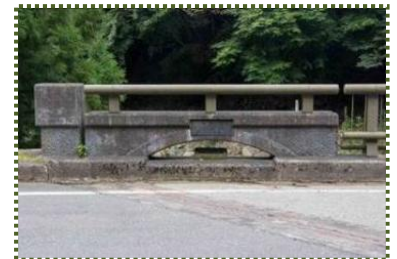
写真-12 国道429号平野橋の高欄
