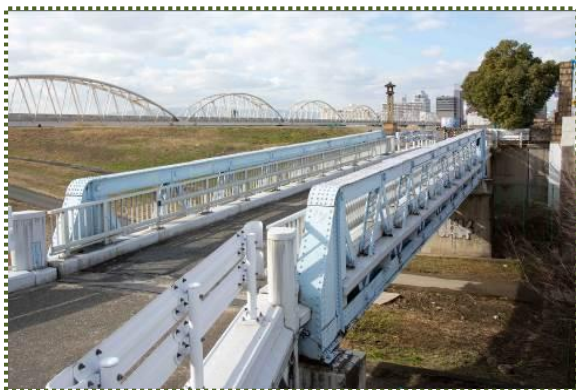
写真-5 撤去された浜中津橋
