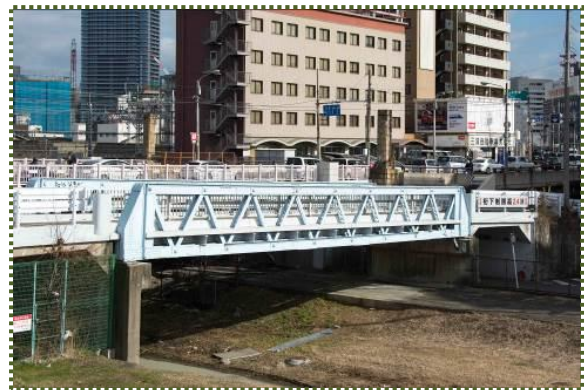
写真-6 撤去された浜中津橋
