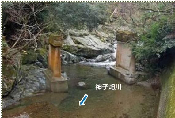
写真-13 山神橋から吊り橋跡を撮影
