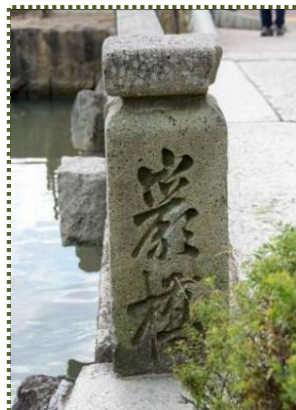
写真-11 親柱③「巖橋」
