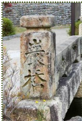
写真-9 親柱①「巖橋」
