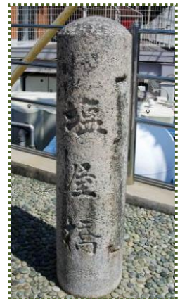
写真-17 塩屋橋親柱
