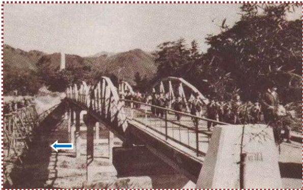
写真-6 岸田川に架かる戸田橋の渡り初め(昭和33年11月8日) 〔『全建ひょうご109号』から引用：浜坂町役場・木本善一氏提供〕
