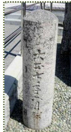
写真-16 塩屋橋親柱
