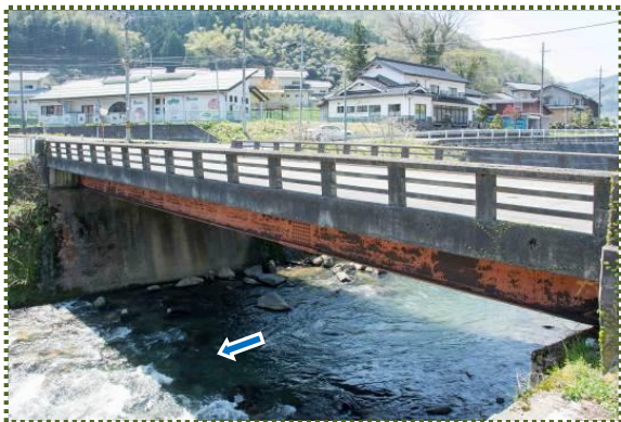
写真-8 矢田川橋(県道橋)
