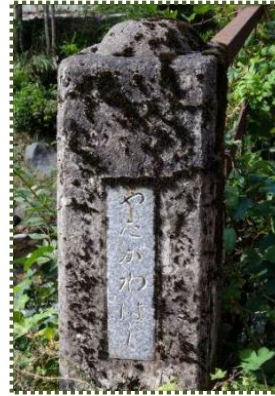
写真-11 右岸側左の親柱
