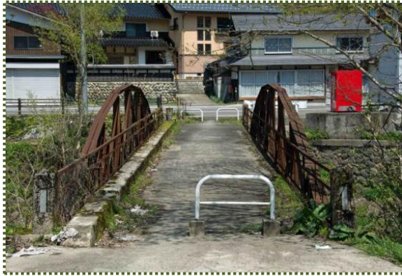
写真-10 右岸側から見る矢田川橋（町道橋 W=2.5m）
