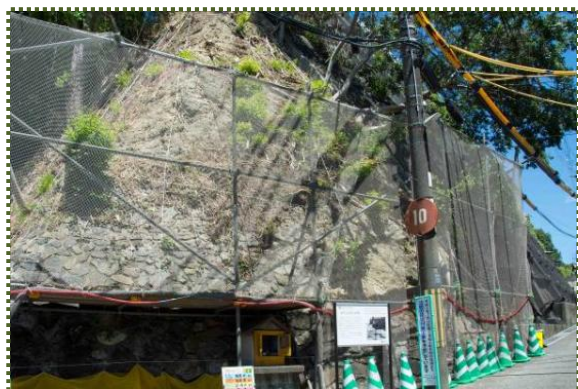
写真-9 工事中の国指定天然記念物「神戸丸山衝上断層」
