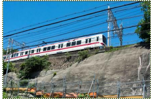
写真-6 上記被災箇所と思われる箇所の現状 (丸山駅北)
