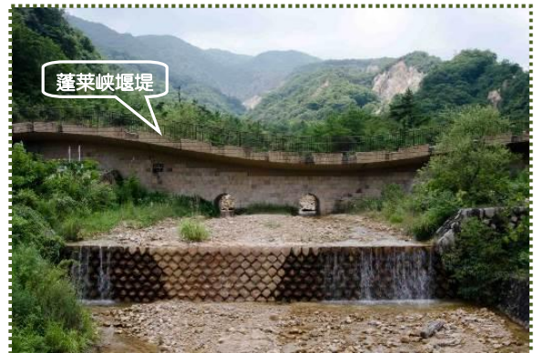
写真-6 下流から蓬莱峡堰堤を撮影
