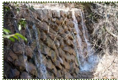
写真-13 まだ大丈夫です! 2 段目鎧積堰堤
