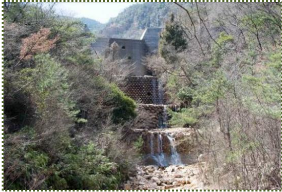
写真-10 四段堰堤
