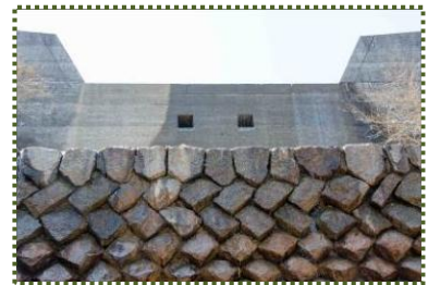
写真-14 しっかりしている 3 段目鎧積堰堤
