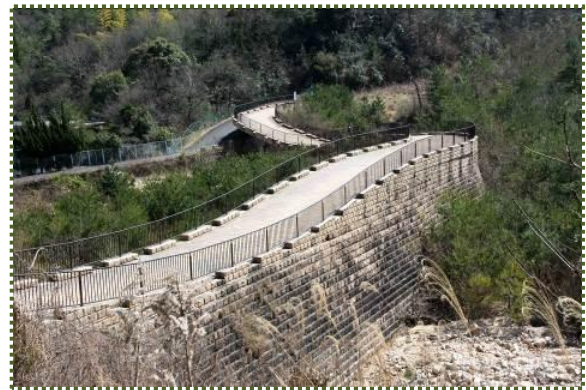
写真-5 蓬莱峡堰堤
