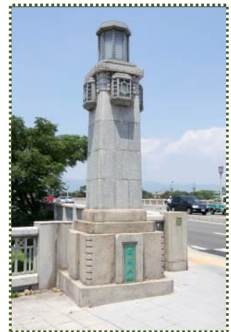
写真-6 武庫大橋の親柱
