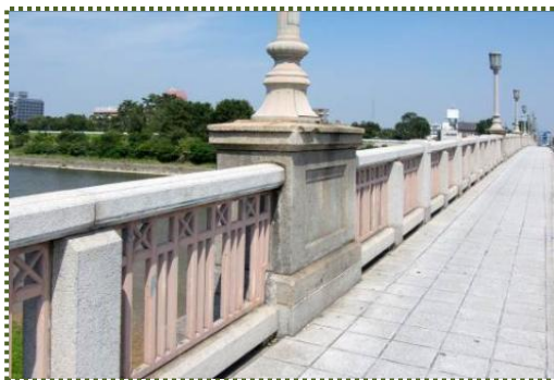
写真-4 武庫大橋の高欄
