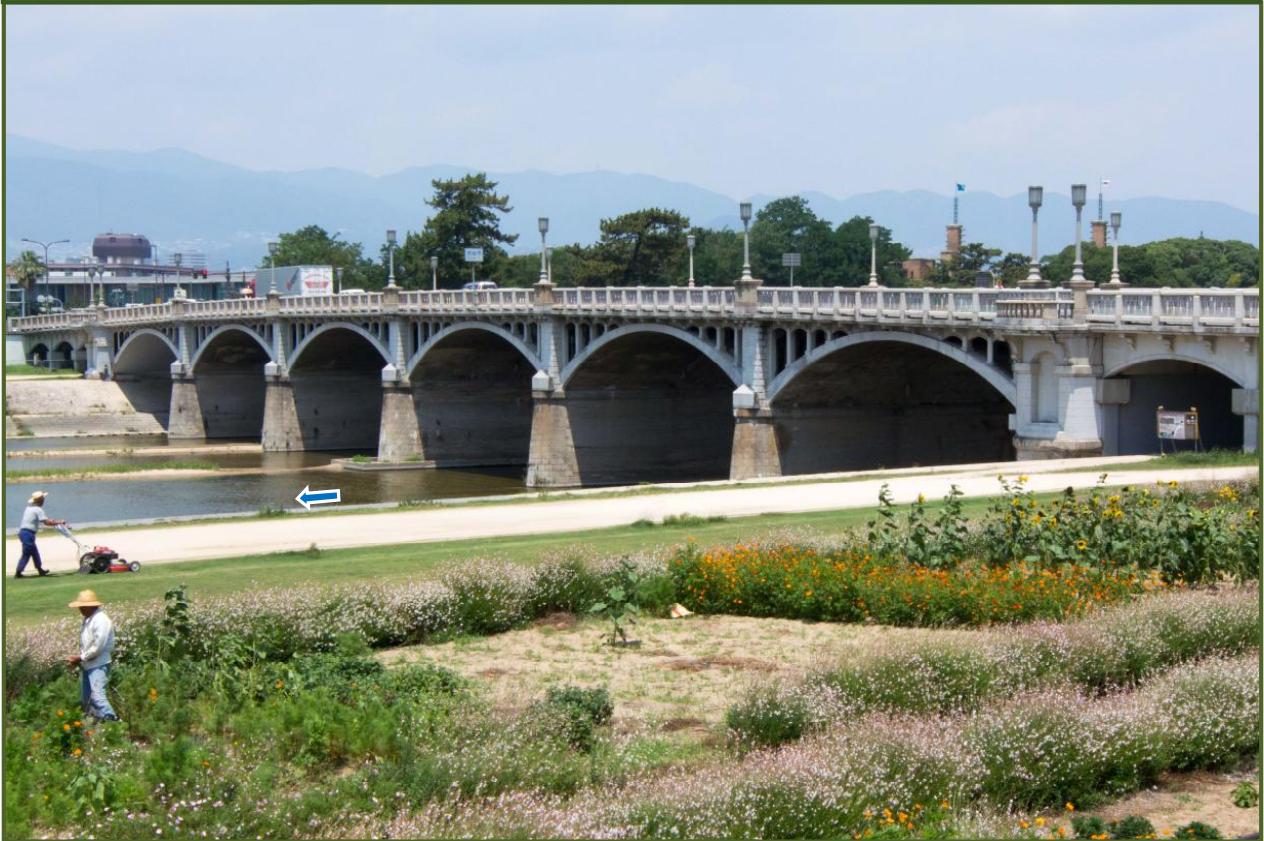
写真-1 武庫川左岸堤防から武庫大橋を撮影（平成25年11月）
