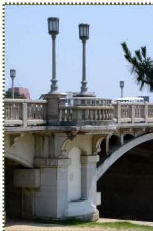
写真-5 武庫大橋のバルコニー
