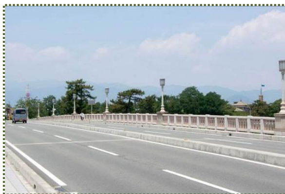
写真-2 国道 2 号武庫大橋
