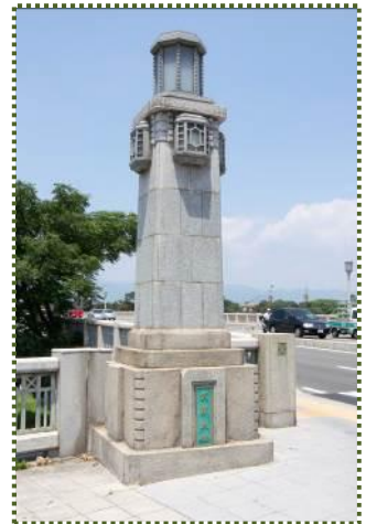
写真-6 武庫大橋の親柱
