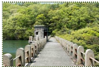
写真-5 山田池堰堤の天端道路
