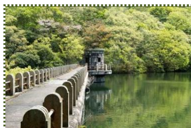
写真-8 山田池堰堤引水塔
