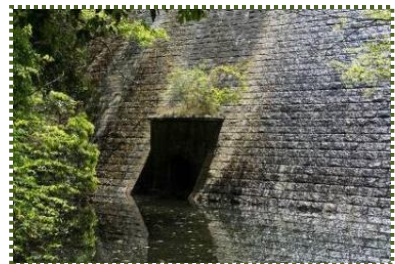
写真-6 伏樋の吐口
