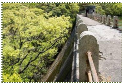
写真-4 天端から下流面を撮影（勾配きつそう！）
