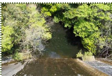
写真-7 堰堤天端から直下を見る
