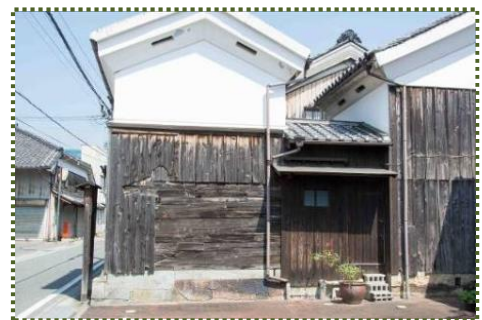
写真-8 舟の底板を利用した舟板壁 (三木市府内町)
