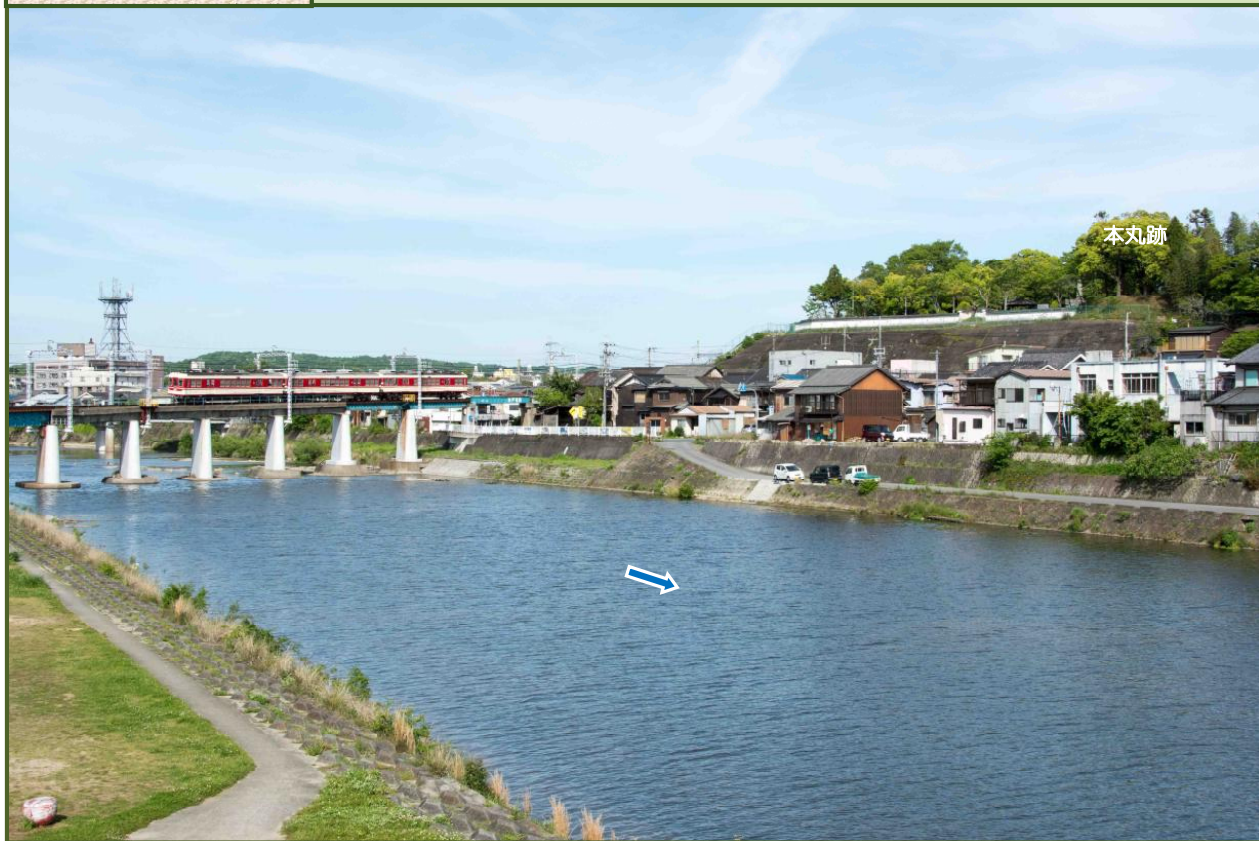
写真-1 城山橋から神戸電鉄・美囊川橋梁と三木城址を撮影（令和元年5月）
