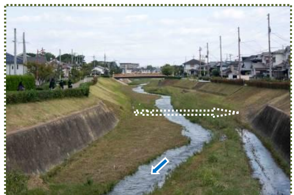
写真-14 喜瀬川を埋樋で越える
