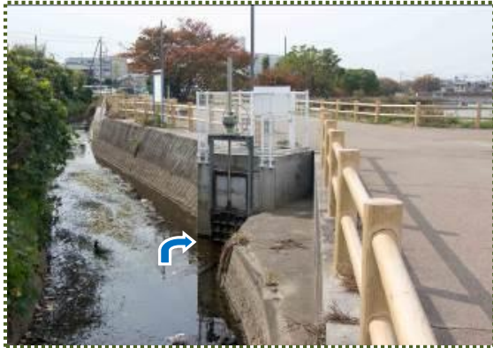
写真-11 峠池への取水樋門
