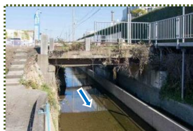
写真-9 新井用水に架かるくんれん橋
