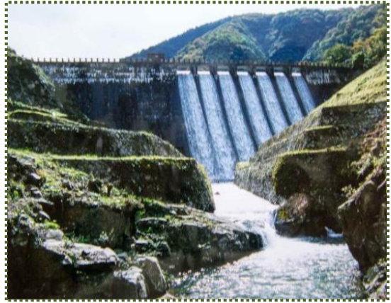
写真-5 成相池堰堤（成相土地改良区提供）
