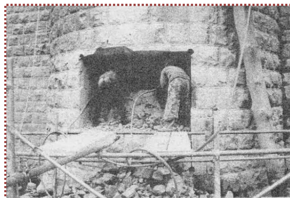
写真-7 取水口の削孔
