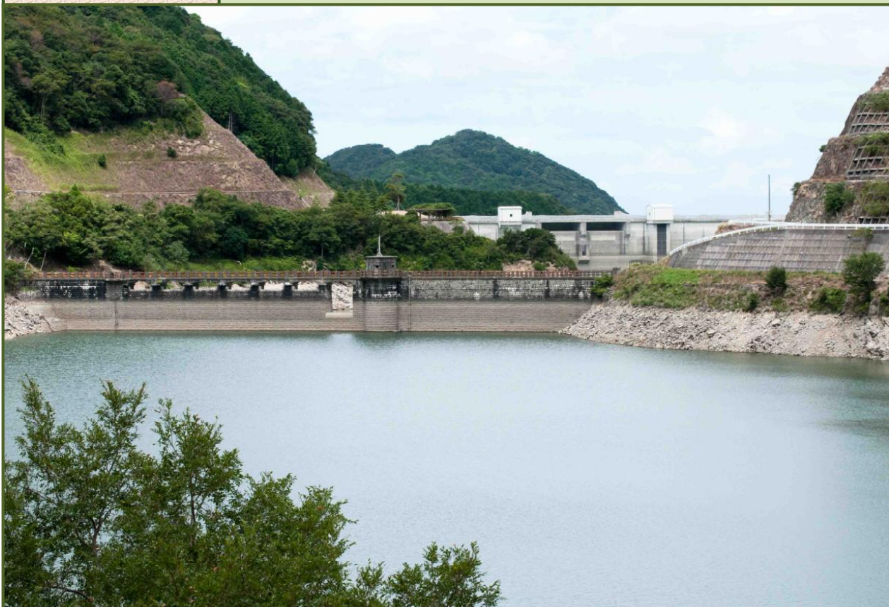
写真-1 成相池堰堤越しに成相ダムを撮影（平成24年8月）
