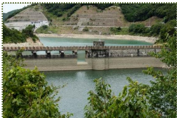
写真-6 成相池堰堤の切り欠き部
