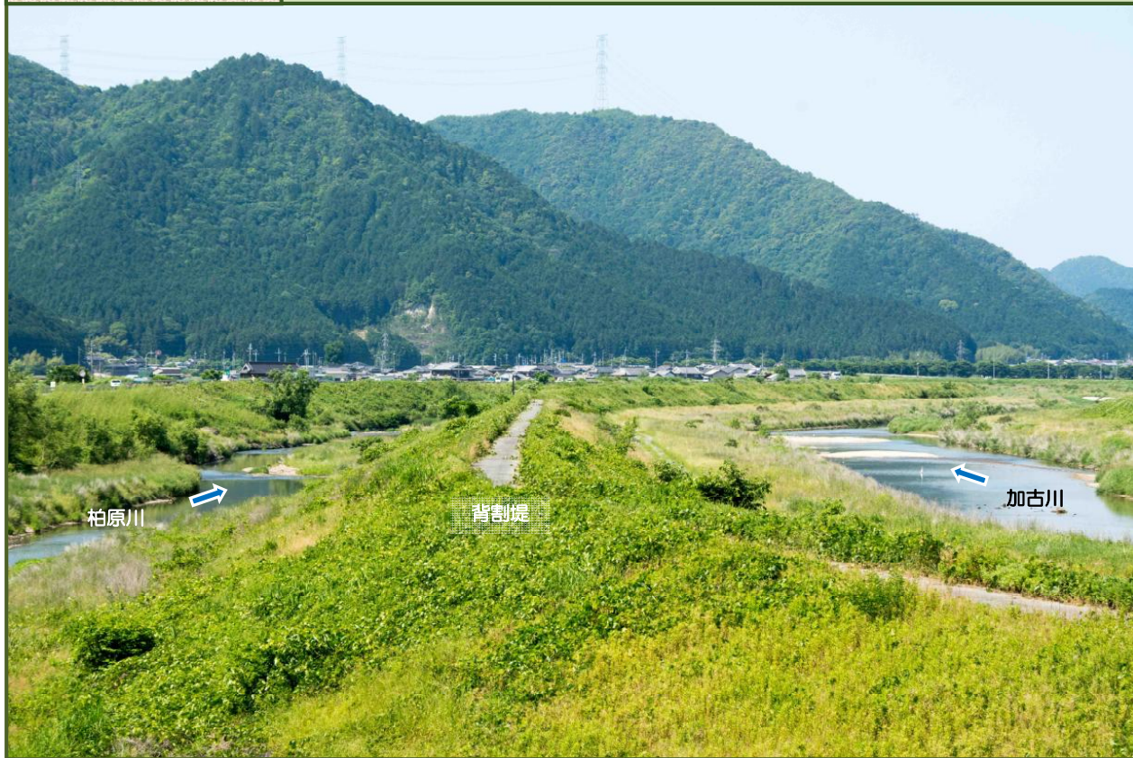
写真-1 稲継樋門から下流を撮影（平成30年6月）
