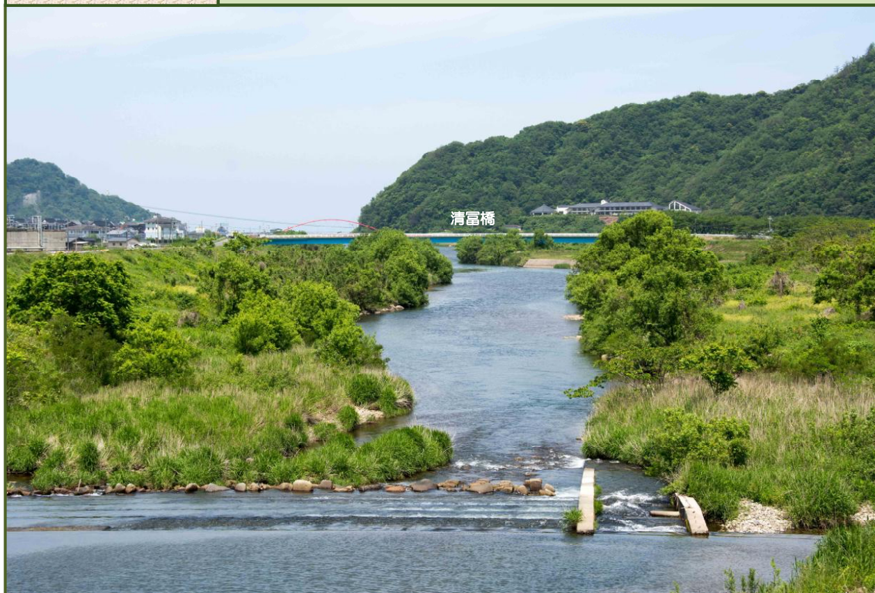
写真-1 福富橋から岸田川下流を撮影（平成27年5月）
