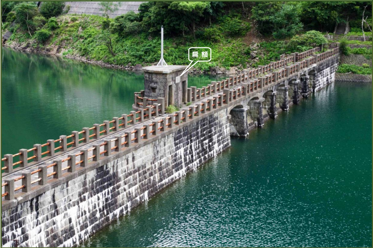
写真-1 成相ダム貯水池に佇む成相池堰堤（平成25年6月撮影）
