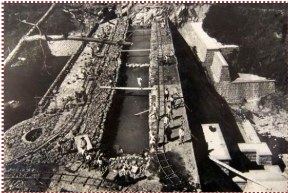
写真-8 全面シヤ打設で横継目がないのがよくわかる
