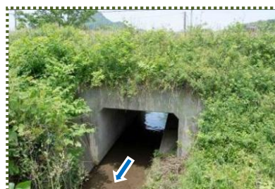
写真-14 JR 山陰本線下のボックスカルバート
