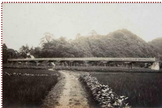
写真-5 戸田橋（木橋）
