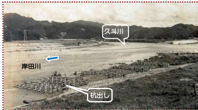
写真-3 久斗川と岸田川の合流部 （合流点下流の岸田川左岸部には杭出し水制工が設けられている）
