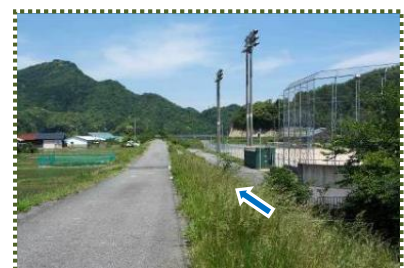
写真-15 道路が旧岸田川の左岸堤防と思われる
