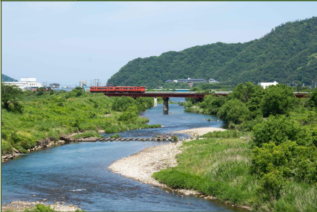
写真-1 戸田橋から岸田川下流&山陰本線を撮影（平成27年5月）
