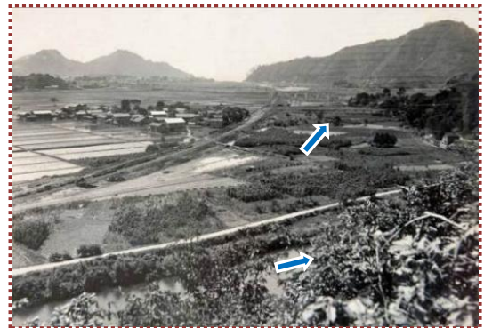
写真-4 新旧岸田川の分岐部から新岸田川の下流方向を望む
