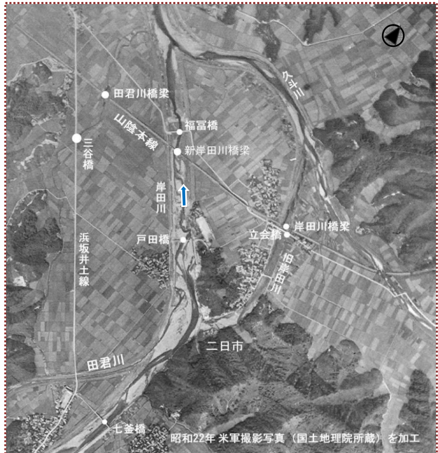
写真-16 昭和 22 年の岸田川下流部の写真
