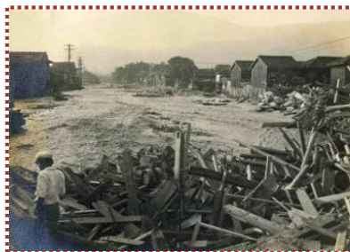
写真-13 省線付近から土砂に埋没した都賀川
