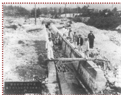
写真-4 杣谷川(?) の暗渠工事
