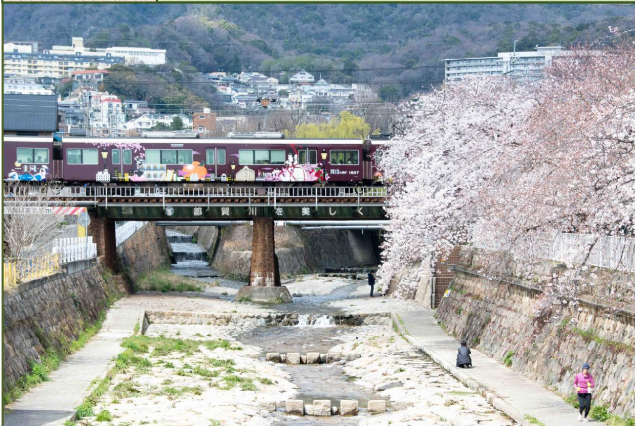
写真-1 甲橋から阪急都賀川橋梁を撮影（平成31年4月）
