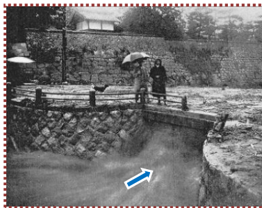
写真-7 六甲川暗渠呑口
