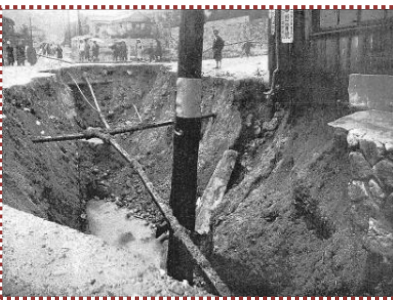
写真-10 六甲川暗渠十間道路交差点付近
