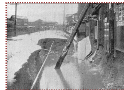
写真-11 六甲川暗渠六間路交差点付近
