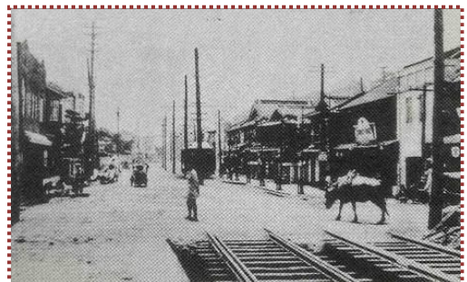
写真-7 大正時代の兵庫電軌塩屋停留所付近の旧国道
