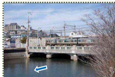
写真-10 山田橋(昭和3年架設)
