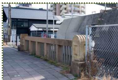
写真-9 朝霧橋(昭和3年8月竣工)
