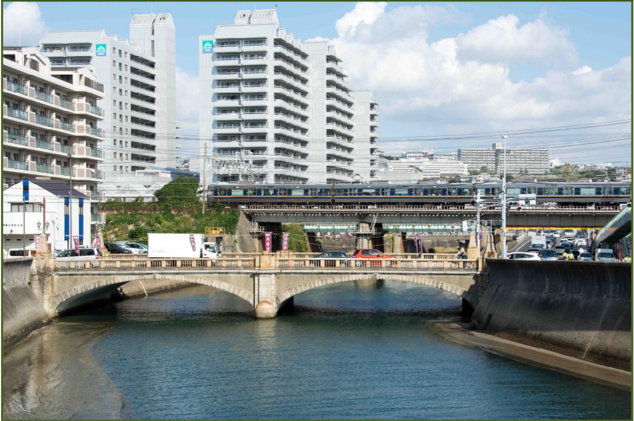
写真-1 福田川右岸パラペット上から国道2号・福田橋を撮影（平成27年10月）
