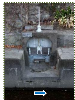
写真-7 北郷用水の取水樋門
