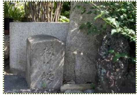
写真-16 枝川橋の親柱
