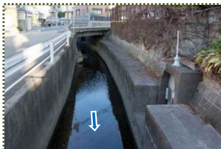
写真-6 新堀川沿いにある取水樋門
