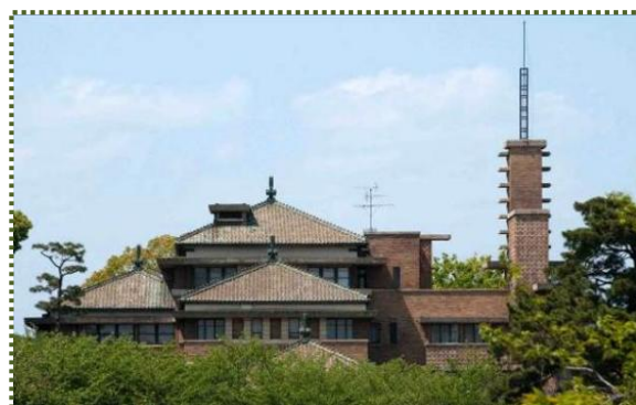
写真-12 武庫川右岸堤防上から旧甲子園ホテルを撮影
