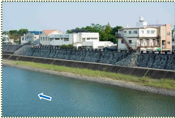
写真-9 五ヶ瀬橋右岸下流の再整備された畳堤
