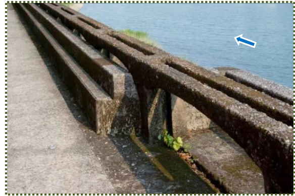
写真-10 五ヶ瀬橋上流左岸の畳堤 (開口部はコンクリート壁で塞がれている)
