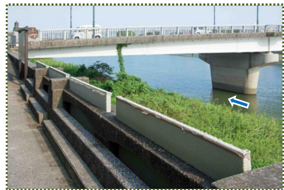
写真-12 デモ用の畳が差し込まれた畳堤
