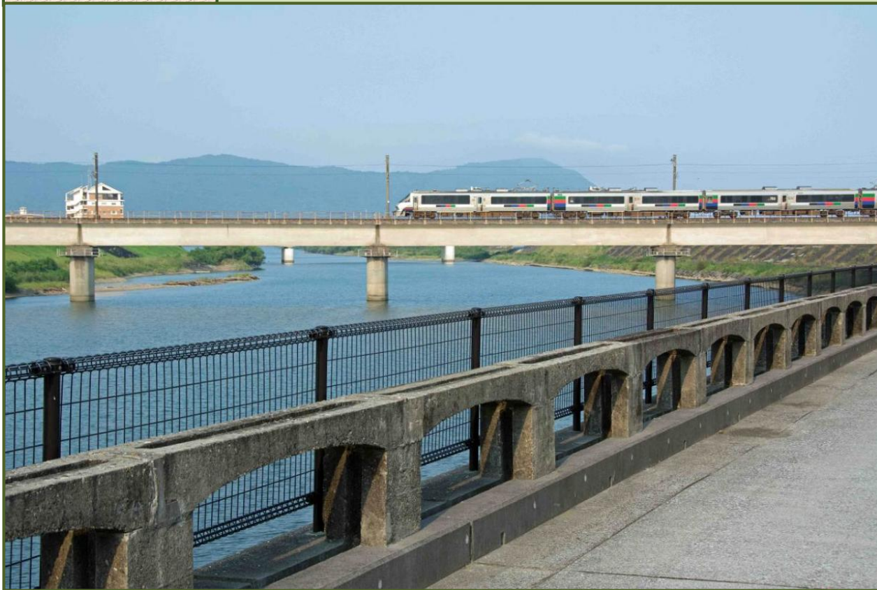
写真-1 五ヶ瀬川右岸下流に再整備された畳堤（平成30年8月撮影）
