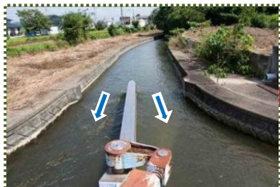
写真-13 七ツ杭分水所
