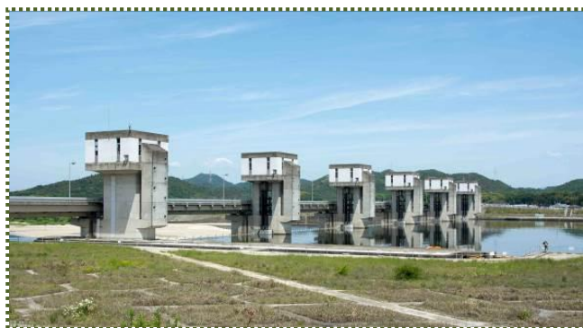
写真-16 加古川大堰
