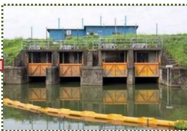
写真-11 曇川樋門
