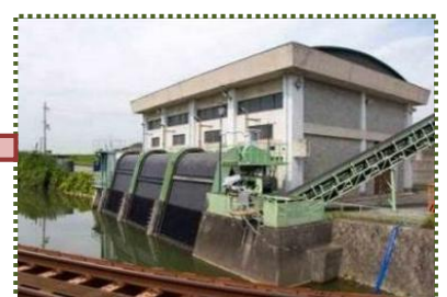
写真-12 曇川排水機場
