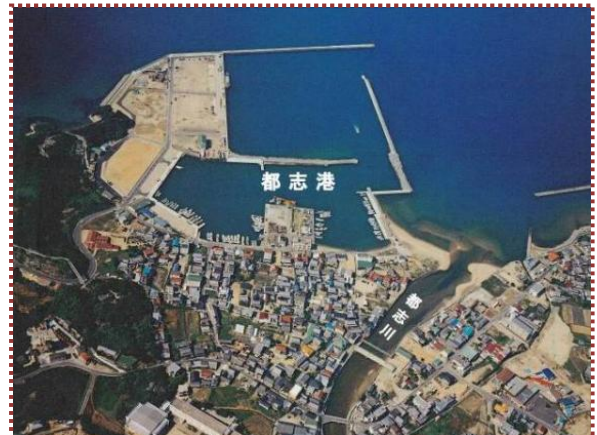
写真-14 都志港空中写真（洲本土木事務所提供）
