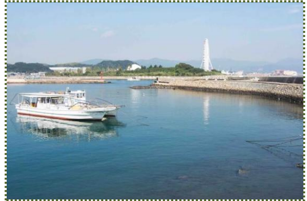
写真-11 塩尾港（平成29年11月撮影）
