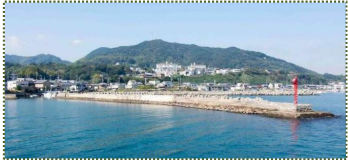
写真-3 塩尾港の東防波堤から北防波堤を撮影
