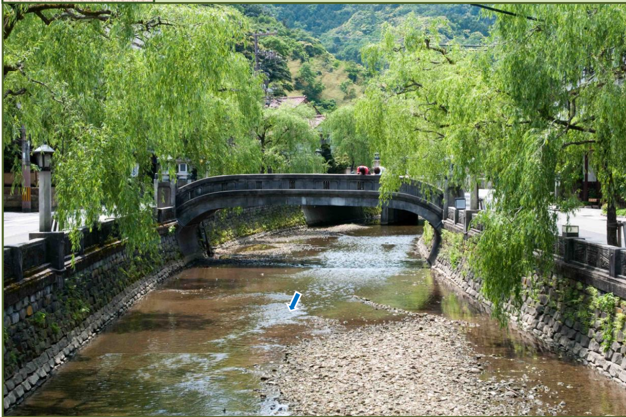
写真-1 柳湯橋から大谿川と愛宕橋を撮影（平成23年5月）
