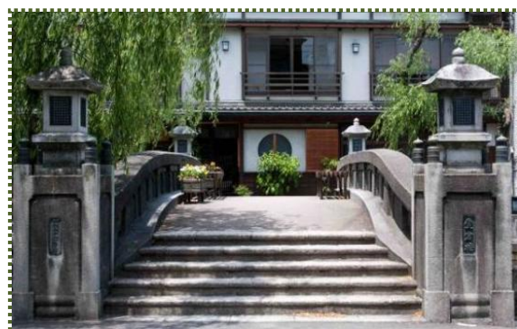
写真-10 大谿川に架かる愛宕橋
