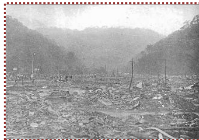
写真-4 城崎町の焼跡(『北但震災誌』から引用)
