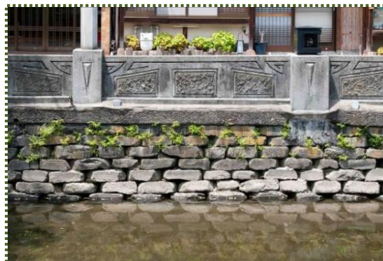
写真-15 玄武岩護岸と側壁
