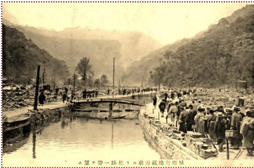
写真-6 城崎町地藏湯前より焼跡一帯を望む(城崎温泉HP「HISTORY 城崎全町崩壊からの復活」から引用)
