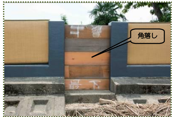
写真-10 畳堤開口部の角落し設置状況
