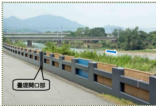
写真-11 堤内側から見た畳の設置状況（7月13日撮影）
