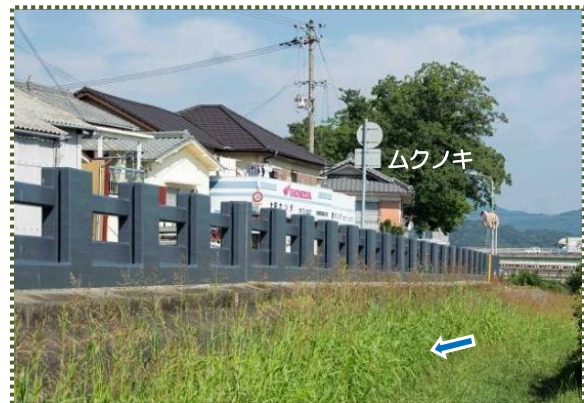
写真-8 堤外側から畳堤を撮影
