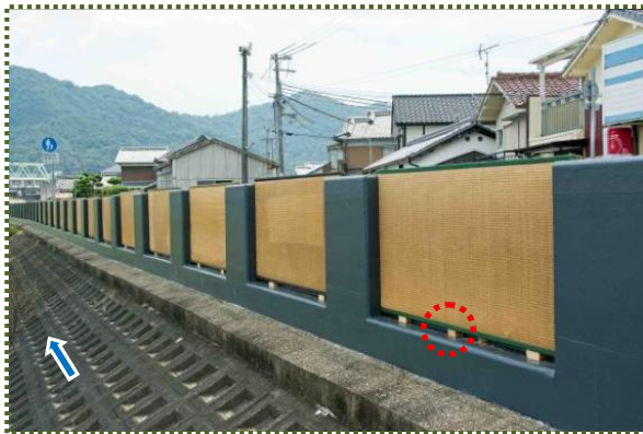
写真-13 堤外側から見た畳の設置状況 (7月13日撮影)
