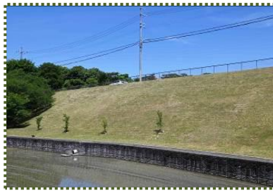
写真-14 ニテコ池 下堤 (令和 2 年 6 月撮影)
