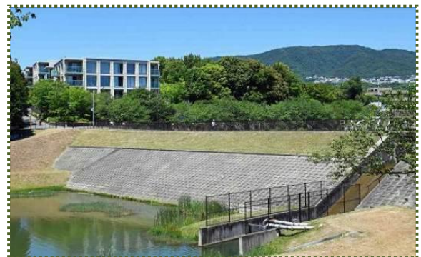
写真-16 現在のニテコ池中堤
