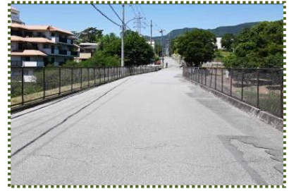
写真-15 ニテコ池 下堤天端 (令和 2 年 6 月撮影)
