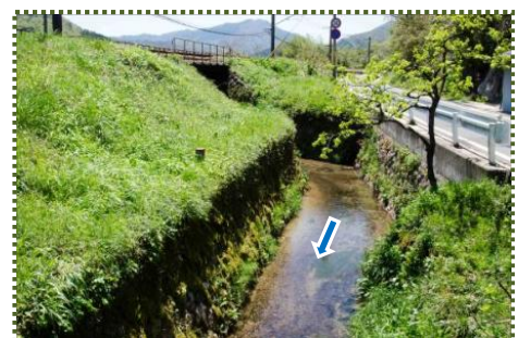
写真-3 山陰本線の下を抜けて来た用水
