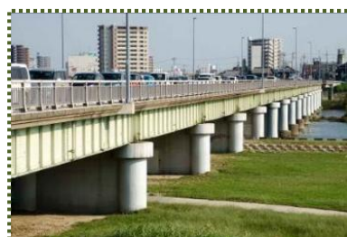
写真-4 国道2号加古川橋
