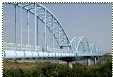
写真-2 加古川水管橋
