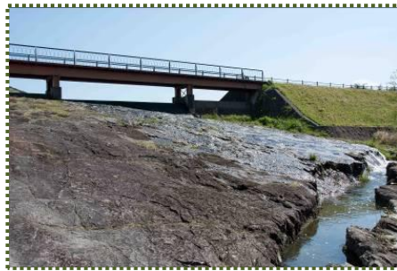
写真-4 露岩地に設けられた洪水吐
