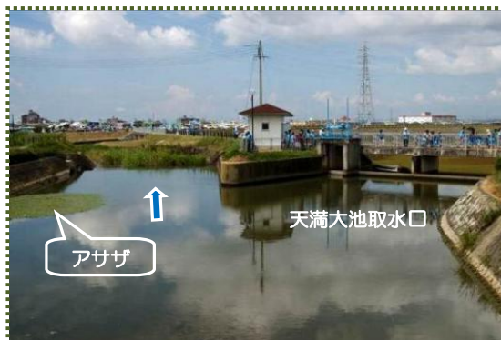
写真-11 天満大池取水口横の喜瀬川
