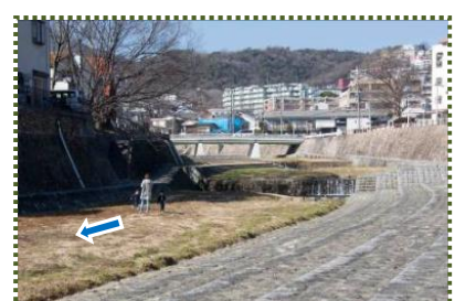
写真-12 現在の越木岩橋と遊砂地
