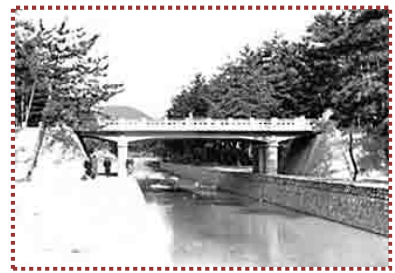
写真-8 苦楽園橋(昭和12年11月竣工)
