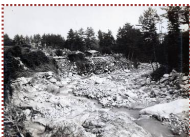
写真-10 獅子ヶ口道路崩壊
