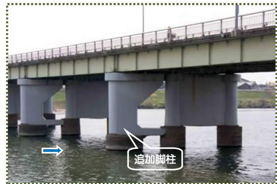
写真-6 加古川橋 脚柱の追加
