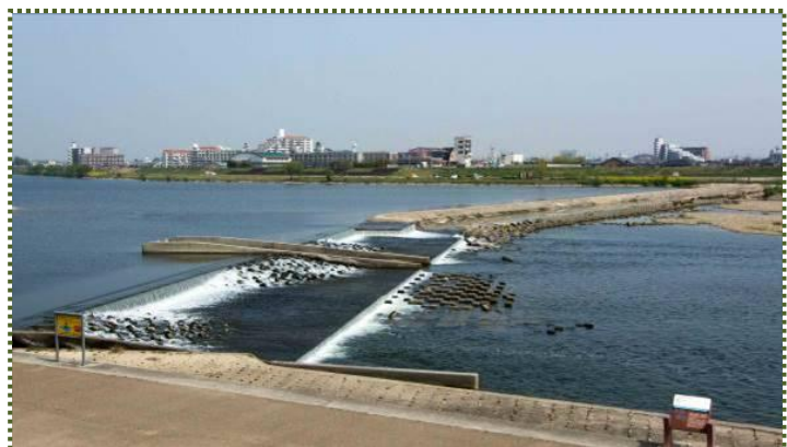
写真-7 古新堰堤
