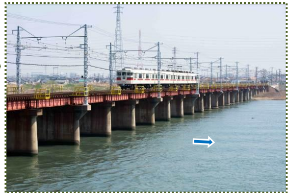
写真-9 山陽電鉄・加古川橋梁
