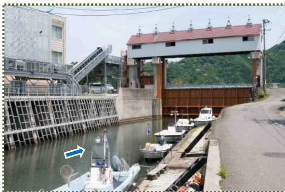
写真-4 大谿川河口の城崎水門
