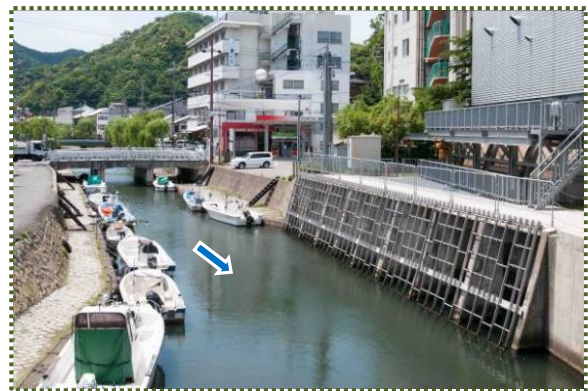
写真-5 右の建物が城崎排水機場
