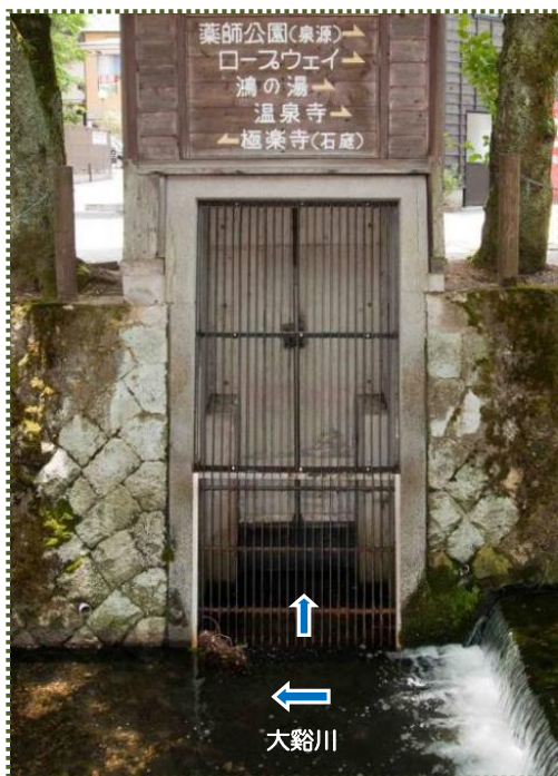
写真-3 導水樋門
