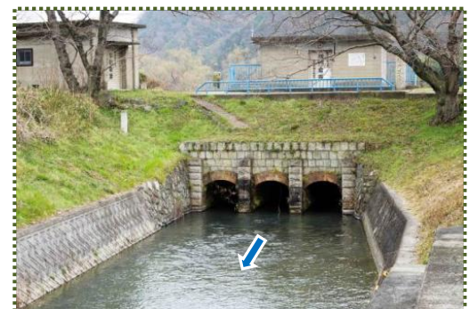
写真-3 飾磨樋門（船場川の上流端）
