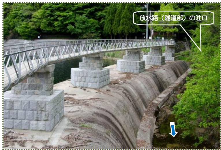
写真-13 横越流型式の洪水吐と放水路
