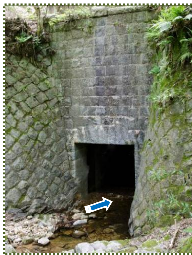
写真-12 放水路呑口
