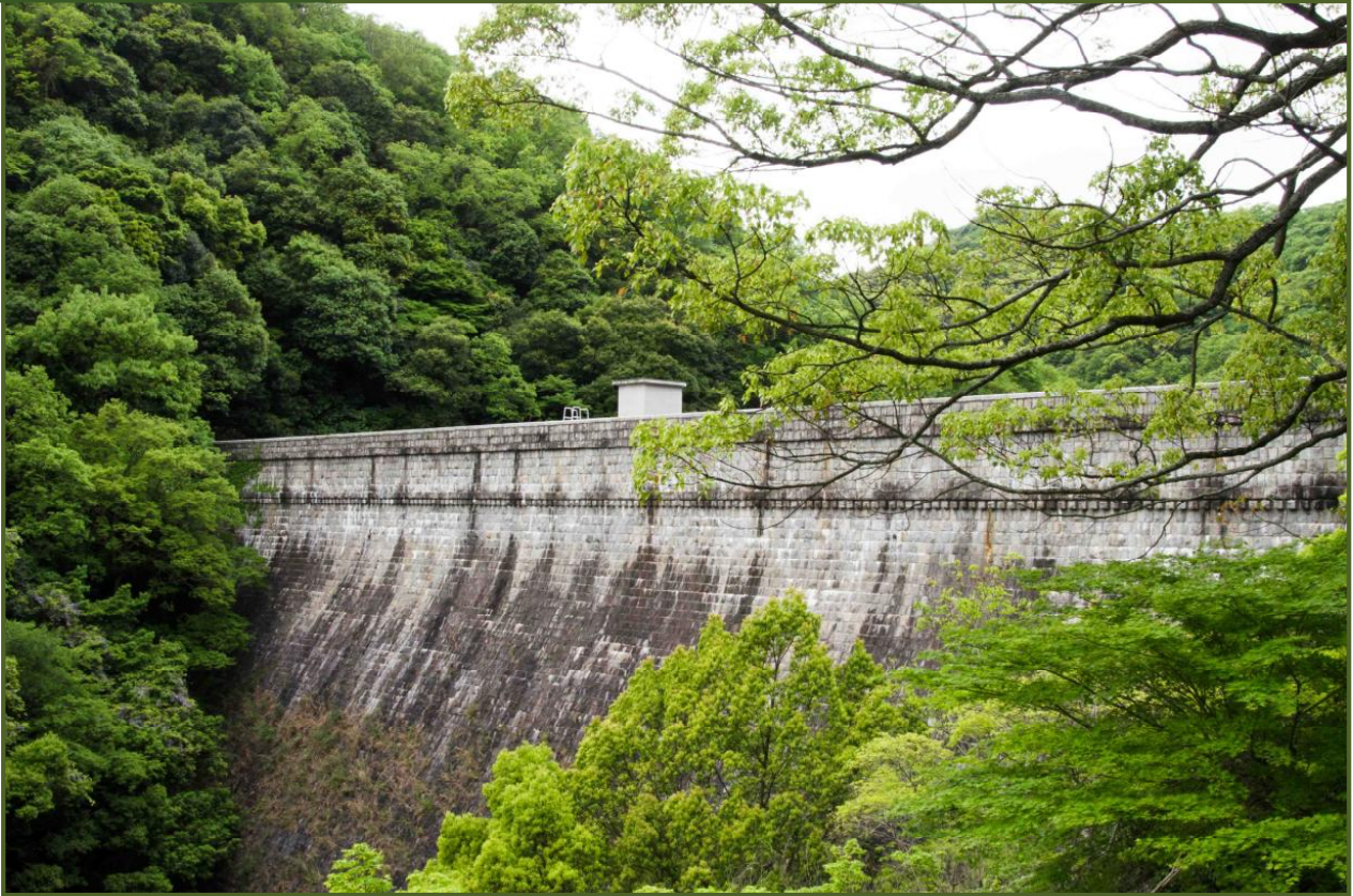
写真-1 布引布引五本松堰堤（平成24年5月撮影）
