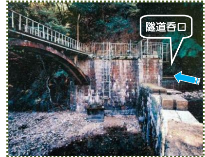
写真-8 分水堰堤
