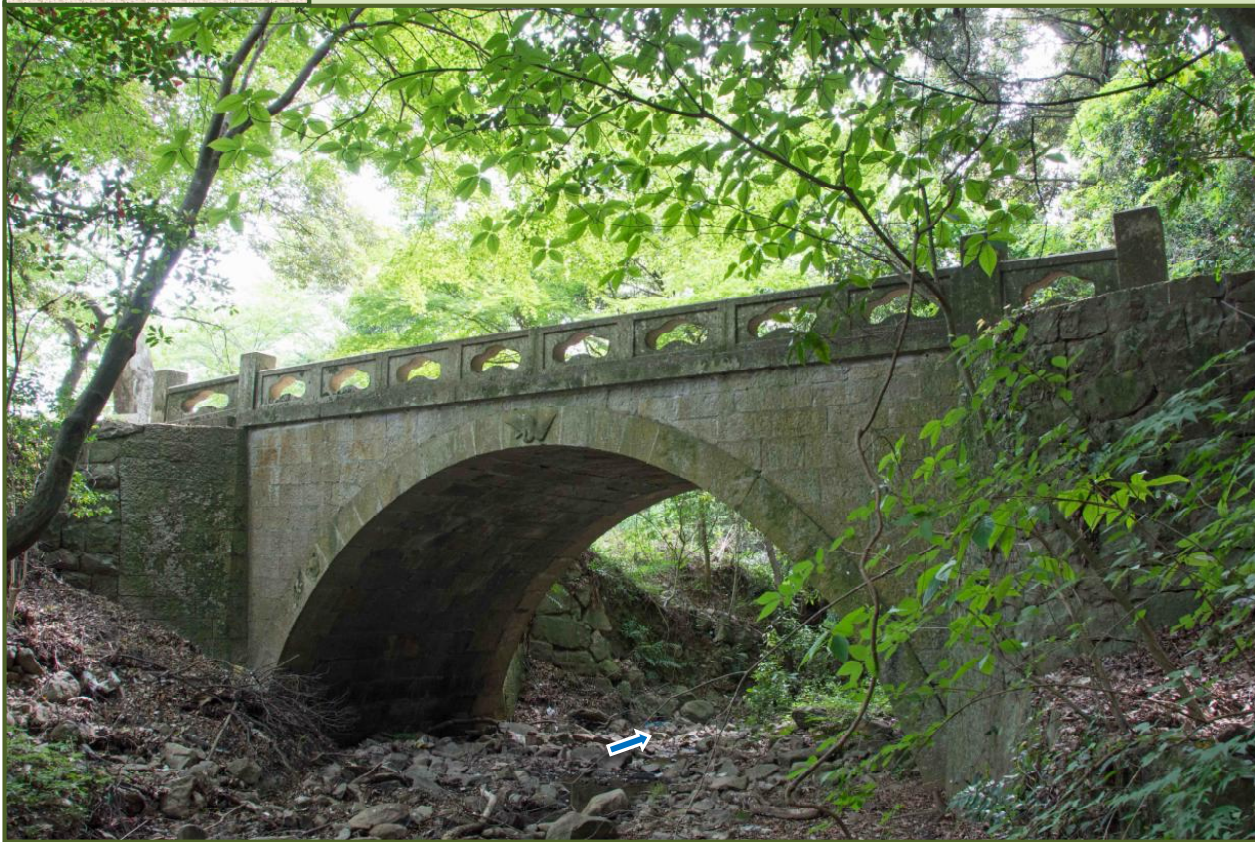
写真-1 石造アーチの八幡橋（平成30年4月撮影）
