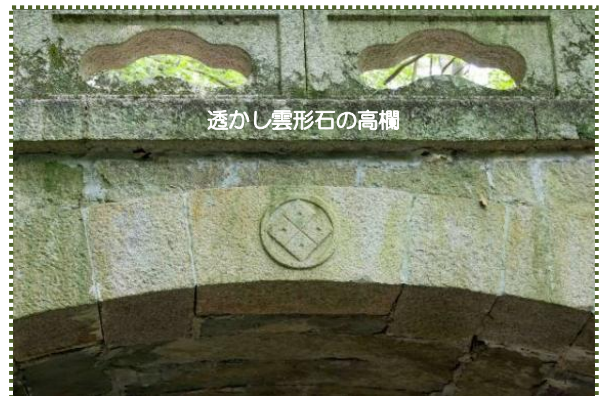
写真-7 下流側要石に「丸に四つ目菱」の陽刻、上の高欄は透かし雲形石
