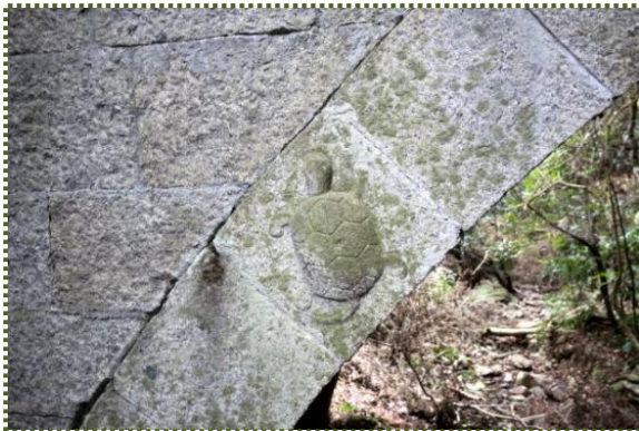
写真-4 上流左岸側 輪石に亀の陽刻
