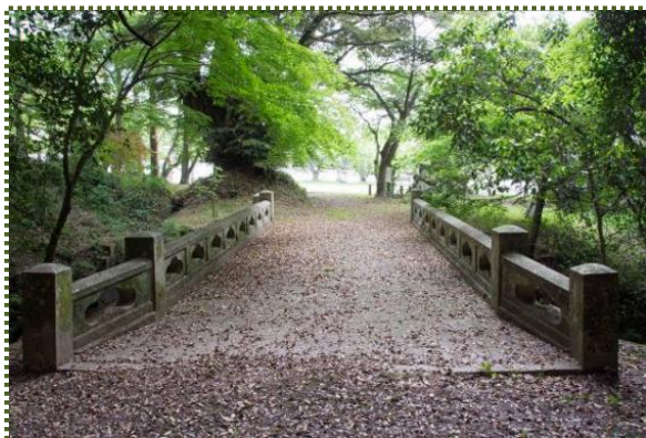
写真-6 右岸側から八幡橋を撮影
