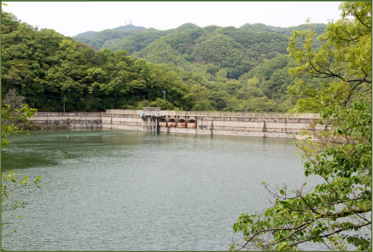
写真-1 烏原貯水池・立ヶ畑堰堤（平成 25 年 6 月撮影）
