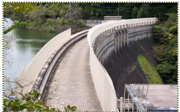
写真-2 曲線重力式粗石モルタル造の立ヶ畑堰堤
