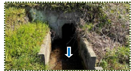
写真-3 送水管の福知山線開口部
