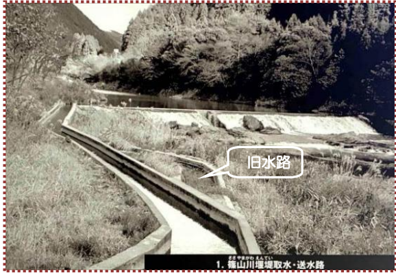
写真-4 篠山川・上滝井堰と導水路
