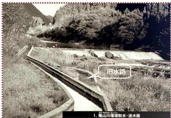
写真-4 篠山川・上滝井堰と導水路
