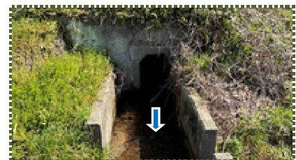
写真-3 送水管の福知山線開口部
