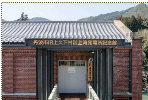
写真-15 丹波市旧上久下村営上滝発電所記念館入口部
