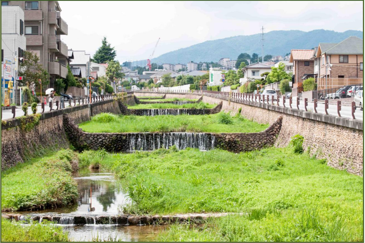
写真-1 菜切橋から逆瀬川中流部の流路工を撮影（平成 23 年 8 月）
