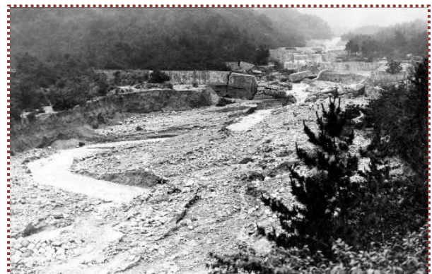
写真-6 阪神大水害で被災した逆瀬川の砂防施設(兵庫県砂防課提供)
