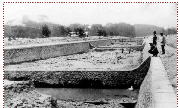
写真-3 流路工施工後の逆瀬川（兵庫県砂防課提供）
