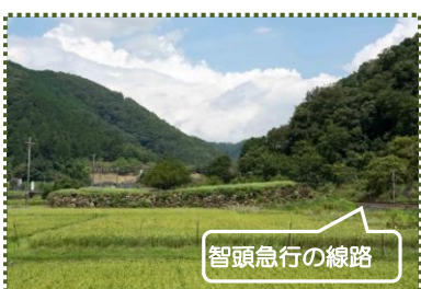
写真-14 南石壁を南から見る
