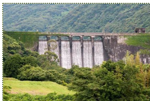
写真-2 上田池堰堤遠望
