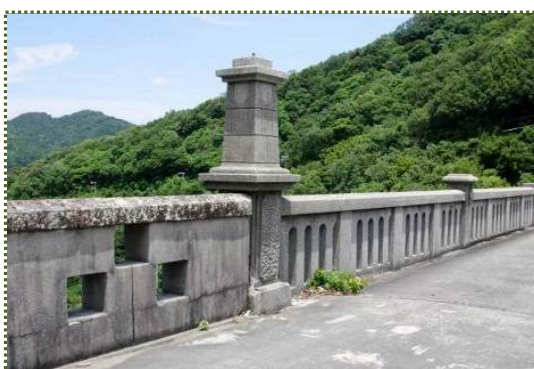
写真-4 上田池堰堤の天端高欄
