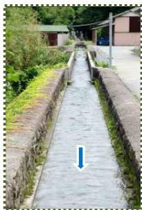
写真-9 空谷川の掛樋
