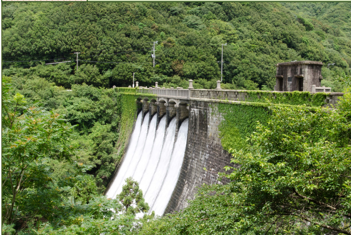
写真-1 上田池堰堤（平成25年6月撮影）
