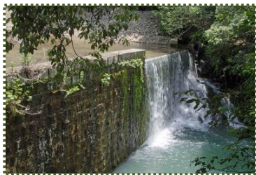
写真-5 取水堰堤 (右岸取水)
