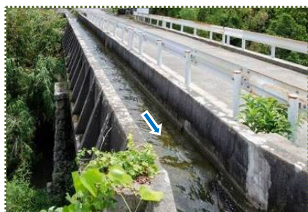
写真-10 論鶴羽川の掛樋 (中原橋)
