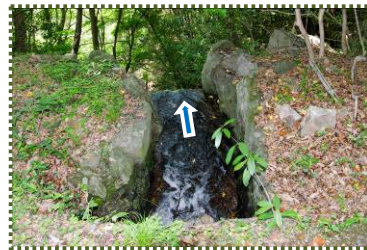
写真-7 ダム直下で斜面中腹にある 既設水路に落とし込む。
