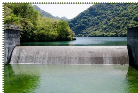
写真-2 大城池洪水吐越流部
