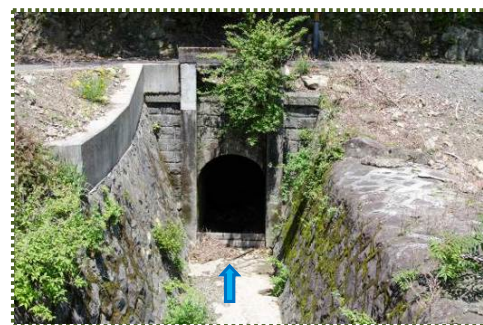
写真-4 放水隧道呑口
