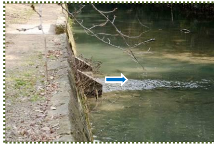
写真-6 取水樋門の吐口部（北部中瀬）
