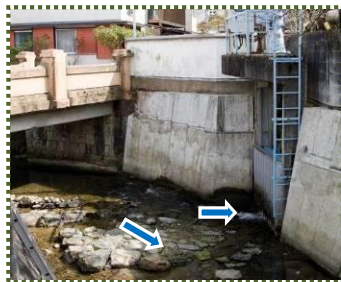
写真-5 坊主橋と取水樋門
