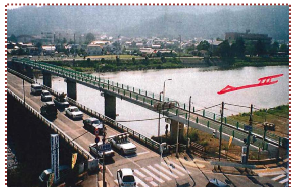
写真-6 側道橋完成後の上郡橋 (上郡橋側道橋橋梁台帳から引用)
