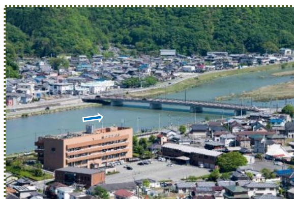
写真-2 生駒山中腹から千種川に架かる上郡橋を撮影
