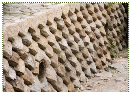
写真-5 逆瀬川の鎧積堰堤
