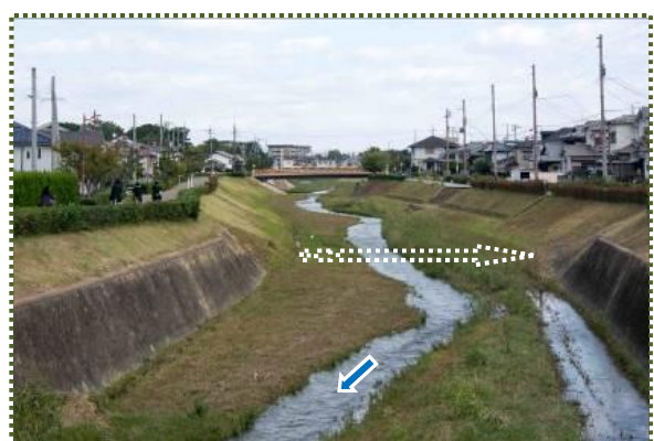
写真-14 喜瀬川を埋樋で越える
