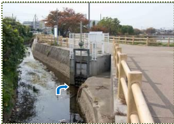
写真-11 峠池への取水樋門
