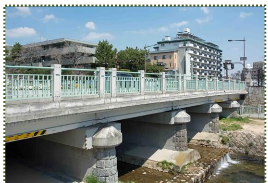
写真-12 大正14年に竣工した業平橋
