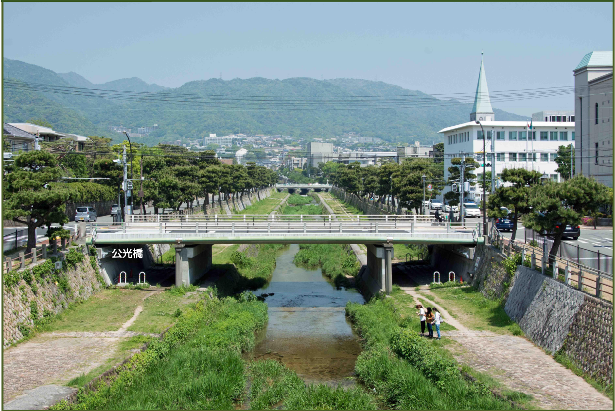
写真-1 阪神電鉄・芦屋駅上りホームから撮影（平成30年4月）
