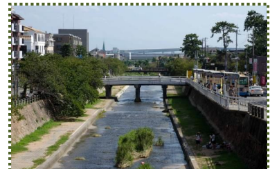
写真-16 月若橋 (阪急芦屋川駅のホームから撮影)
