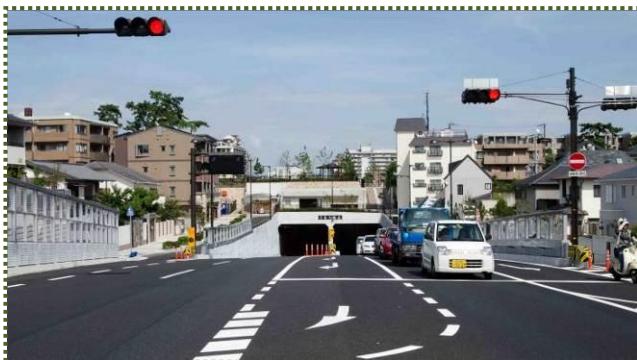
写真-19 山手幹線・芦屋川隧道
