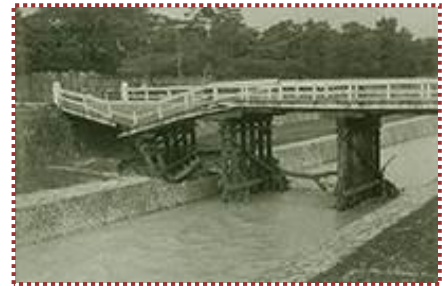
写真-10 公光橋倒壊（昭和 42 年 7 月） （芦屋市 HP「芦屋思い出写真館」より引用）
