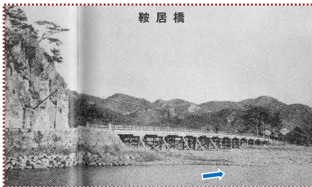
写真-3 木造の鞍居橋 (『むかしの西播磨』から引用・加工)
