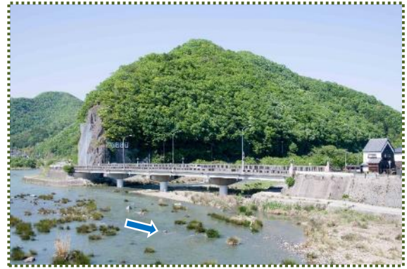
写真-7 建武橋 (令和4年4月撮影)
