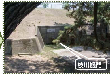
写真-13 枝川樋門
