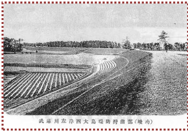
写真-4 尼崎 西大島左岸堤防(竣工)
