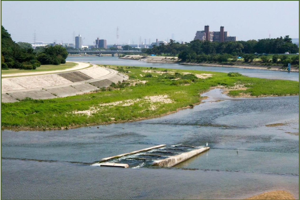
写真-1 国道2号 武庫大橋から下流を撮影（平成25年7月）
