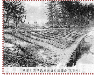
写真-5 武庫川橋付近左岸護岸(工事中)
