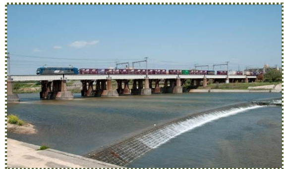
写真-2 JR西日本・武庫川橋梁
